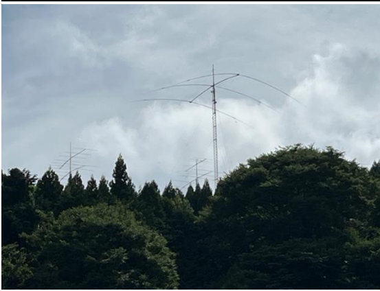
アンテナ全景
